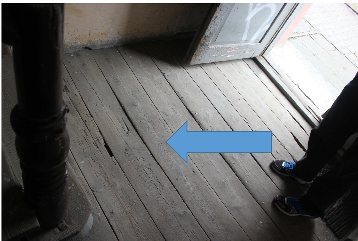
Fot. 12 – sprężynujący podest
