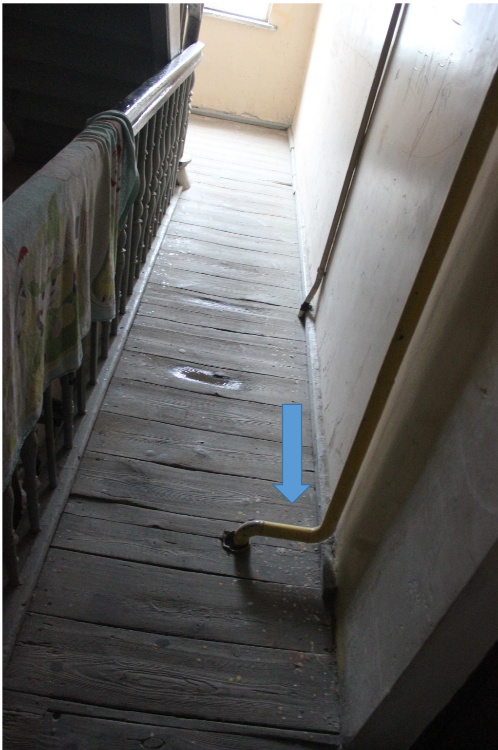
Fot. 13 – rura gazowa na drodze ewakuacyjnej
